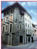
Edificio Monumentale di Aosta
